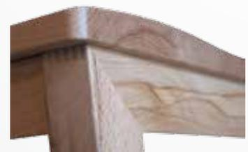
Vorderfuß mit Seitenzarge auf Gehrung mit einer Kronenfugenverbindung.
